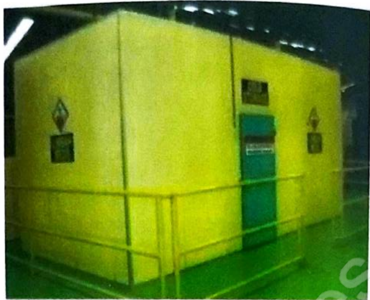
Gambar 5. Contoh ruang pendingin untuk penyimpanan Limbah B3 berupa Limbah infeksius, benda tajam, dan/atau patologis
